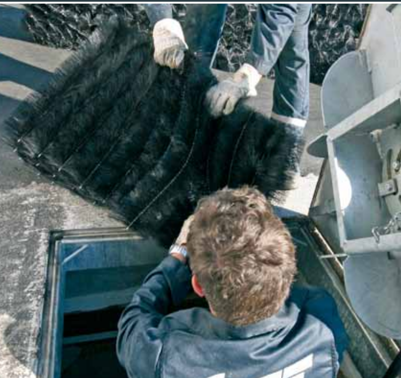
▼ Hauchdünne Kunststoffäden bilden winzige Zwischnräume
